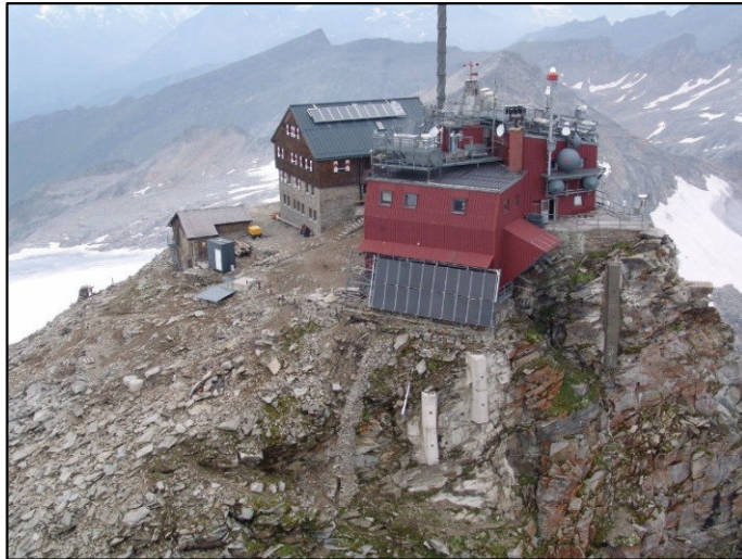
Figure 4: Sonnblick Observatorium mit Stützverbauungen. (c) ZAMG.
