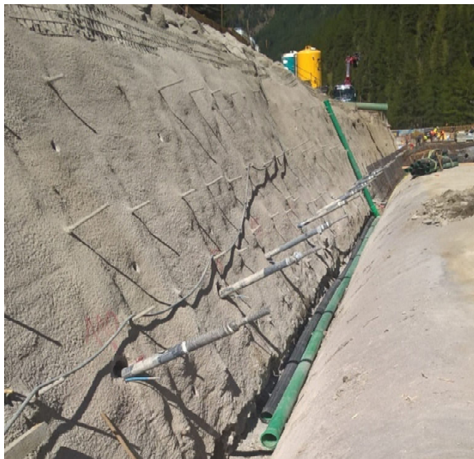
Bild 8: Verpressanker
