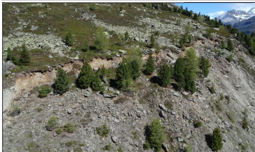
Abb.5. Frisch aufgegangene Absetzung und höchste Begrenzung des Großrutschung mit ca. 6m Absetzung.
