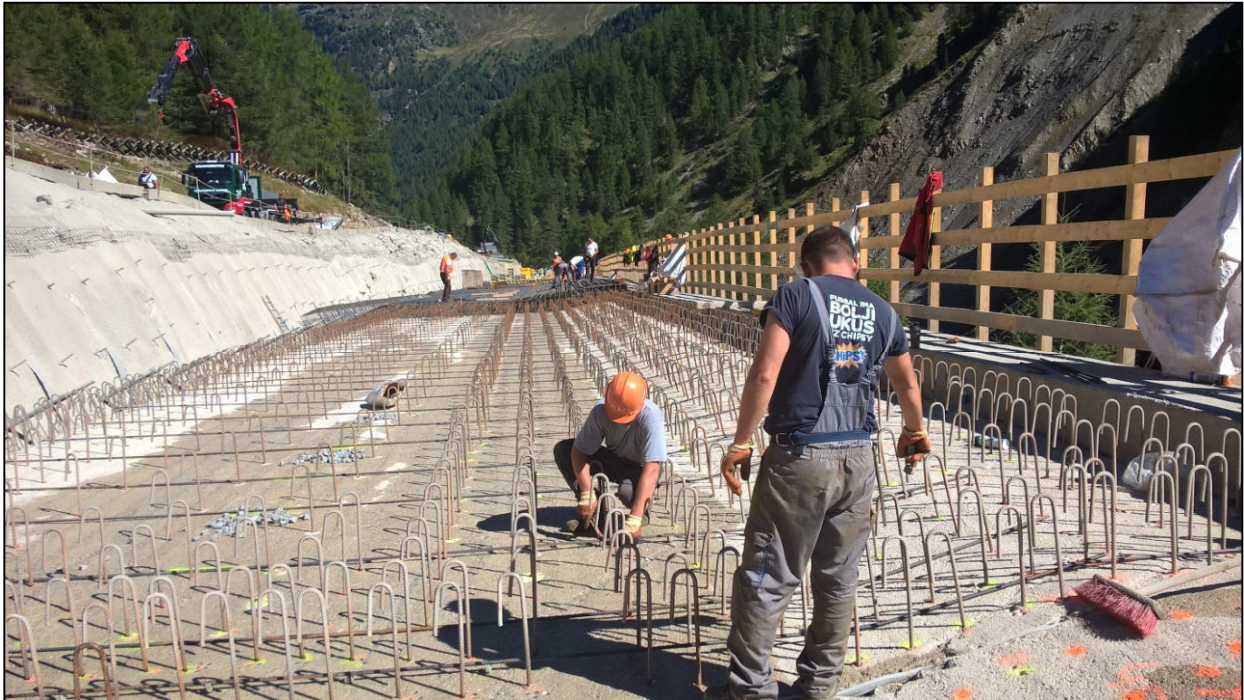
Bild 9: Schubverdübelung
